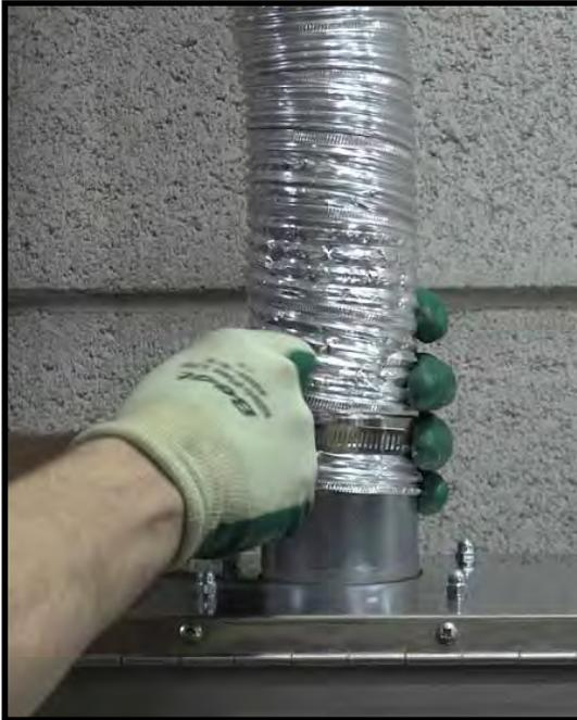
Évacuez les vapeurs à l'extérieur du bâtiment ou reliez la cheminée au système d'évacuation du bâtiment à l'aide d'un conduit flexible en aluminium de 3".
