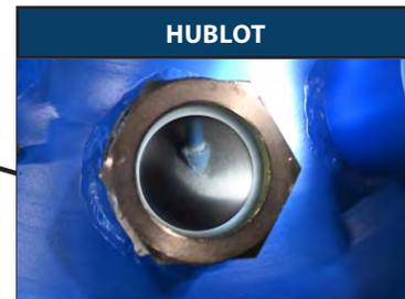
Le voyant en verre permet de vérifier le niveau du média à l'intérieur du réservoir.
