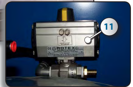
Assemblage de l'interrupteur de défaut de vacuum
