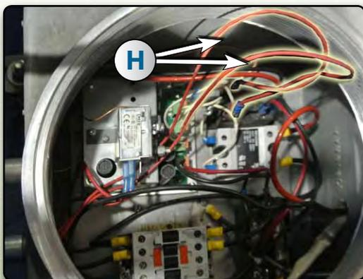
8. Raccorder les 2 fils rouges **H** de la valve solénoïde valve au relais tel que montré ci-contre. (respecter schéma électrique)
