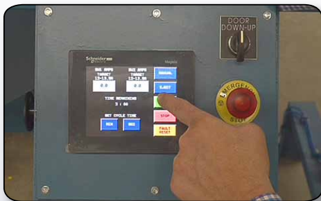
Procédé contrôlé par un HMI
