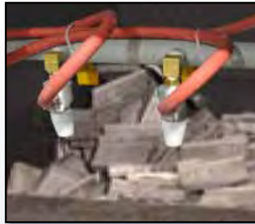
Vue interne : détail des buses
