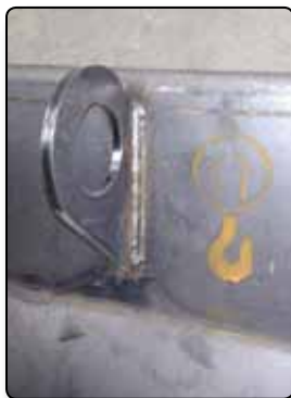
Point d'ancrage de levage
