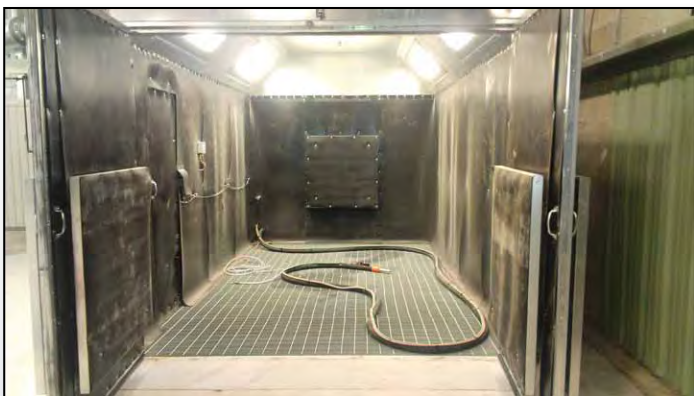
Plancher de récupération complet
