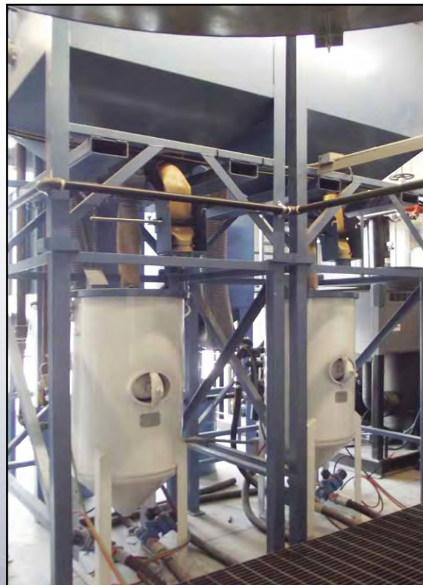
Trémis de stockage et vaisseau sous pression
