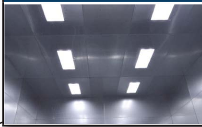
Système d'éclairage à DEL
