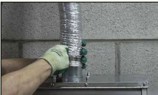
Évacuez les vapeurs à l'extérieur du bâtiment ou reliez la cheminée au système d'évacuation du bâtiment à l'aide d'un conduit flexible en aluminium de 3".
