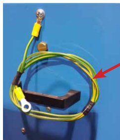
Fil de mise à la terre
